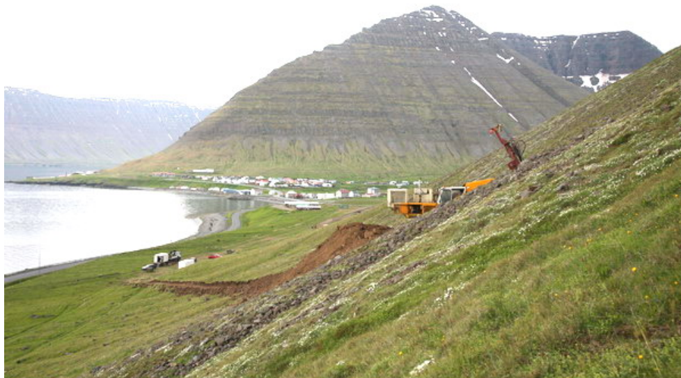
Mynd 25. Mjög þykk skriða liggur utan á berginu við Skarfasker. Þar sem borinn stendur í um 5 m djúpri gryfju við borun holu OL-27, reyndist vera um 9 m á klöpp (borað var með 32^\circ halla þvert inn í hlíð) auk dýpt gryfjunnar. Holur OK-14 og OK-15 voru boraðar á sama stað.
