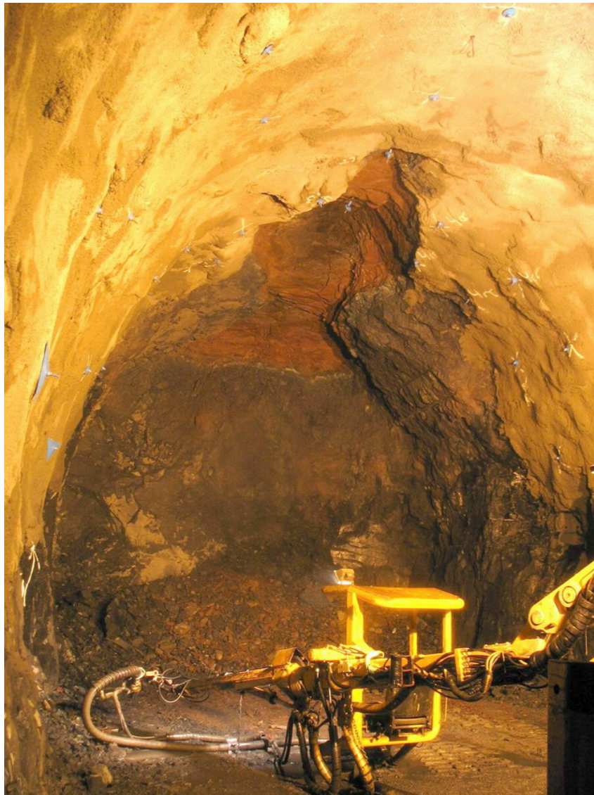
Mynd 21. Leirkennd setbergslög eins og þau sem kennd eru við Breiðhillalagið hafa mjög lágan brotstyrk og valda þá stundum staðbundinni og óreglulegri víkkun á
