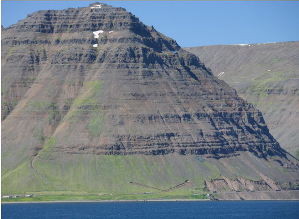
Mynd 10. Aðstæður við fyrirhugaðan munna ofan við Skarfasker. Þykk skriða hylur neðsta hluta hlíðarinnar.
